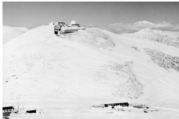
宇宙線観測所 コロナ観測所 肩の小屋
