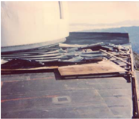
（強風で剥がされた分光室のトタン屋根）
