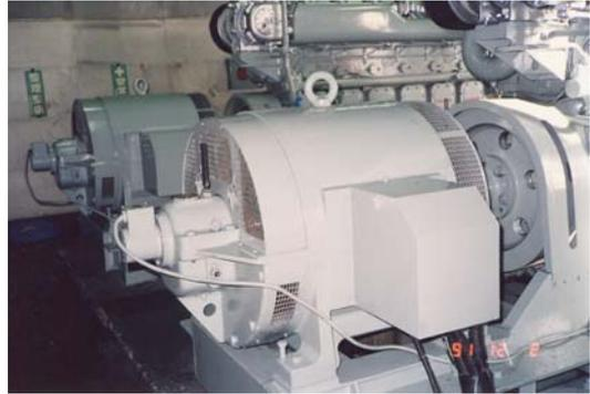
発電機 三菱電機製 発電能力 150KVA
