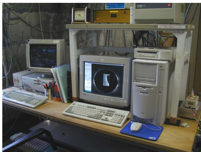
NOGIS 制御装置
