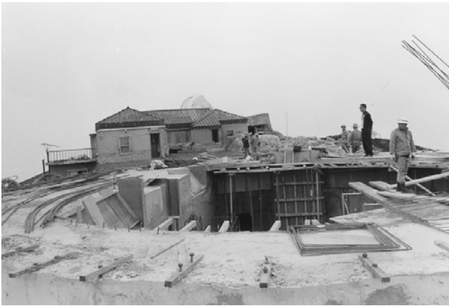
ドーム部工事
