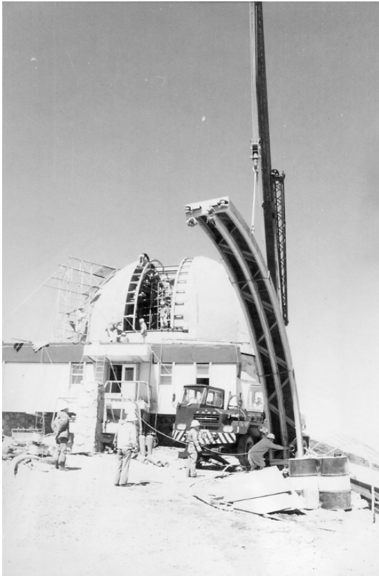
スリット吊り上げ
