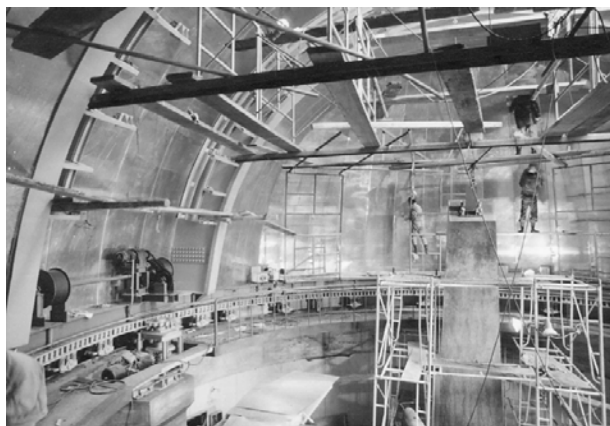
ドーム内壁張り
