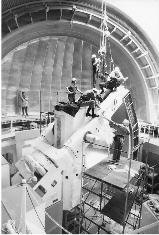
望遠鏡中下部をヨーク部と連結
