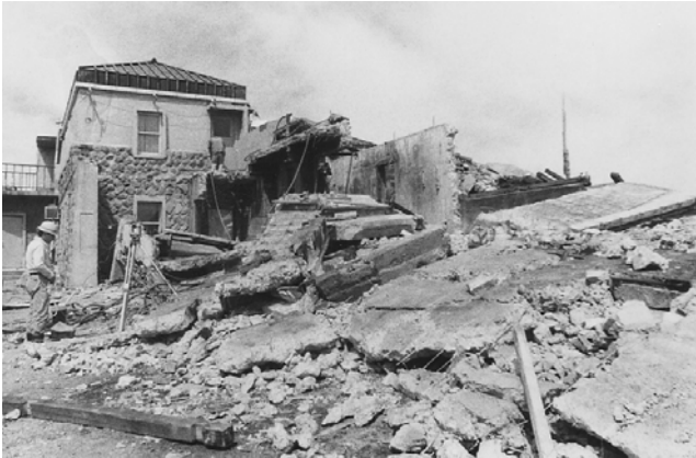
旧エンジン室解体工事
