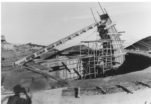
北ピアコンクリート打ち
