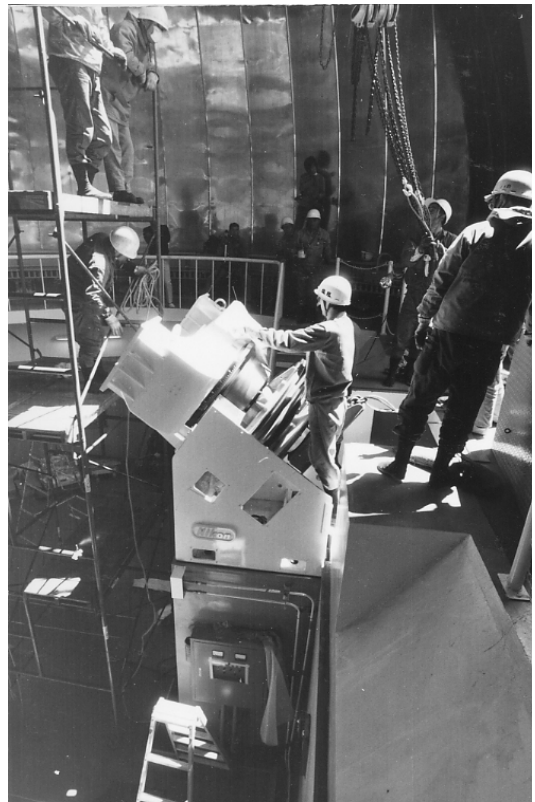
ヨーク下部を軸受けに取り付け
