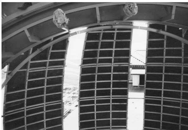
内部鉄骨組み
