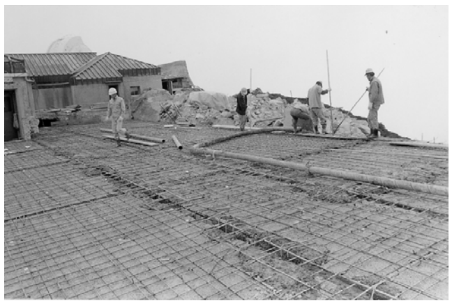
屋上鉄筋工事
