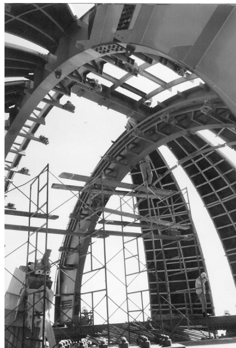
ドーム内足場組み
